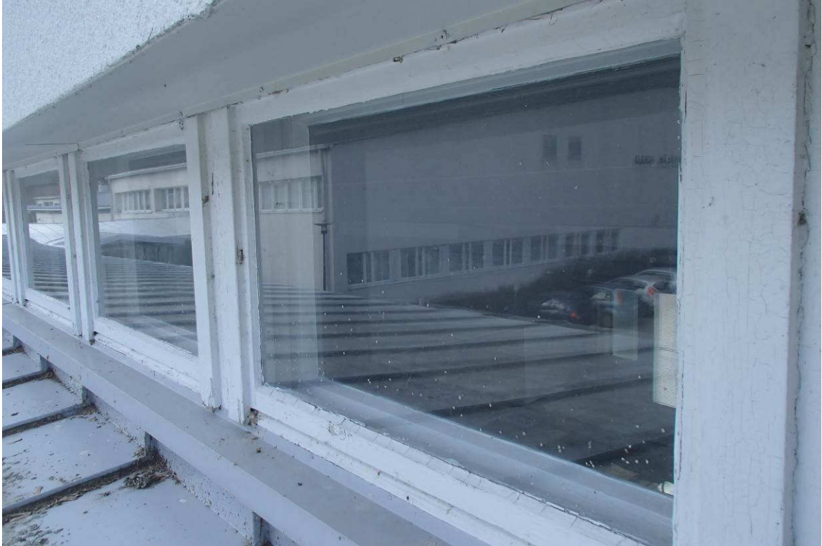
Kuva 6. Yleiskuva luokkahuoneiden yläikkunoista.
