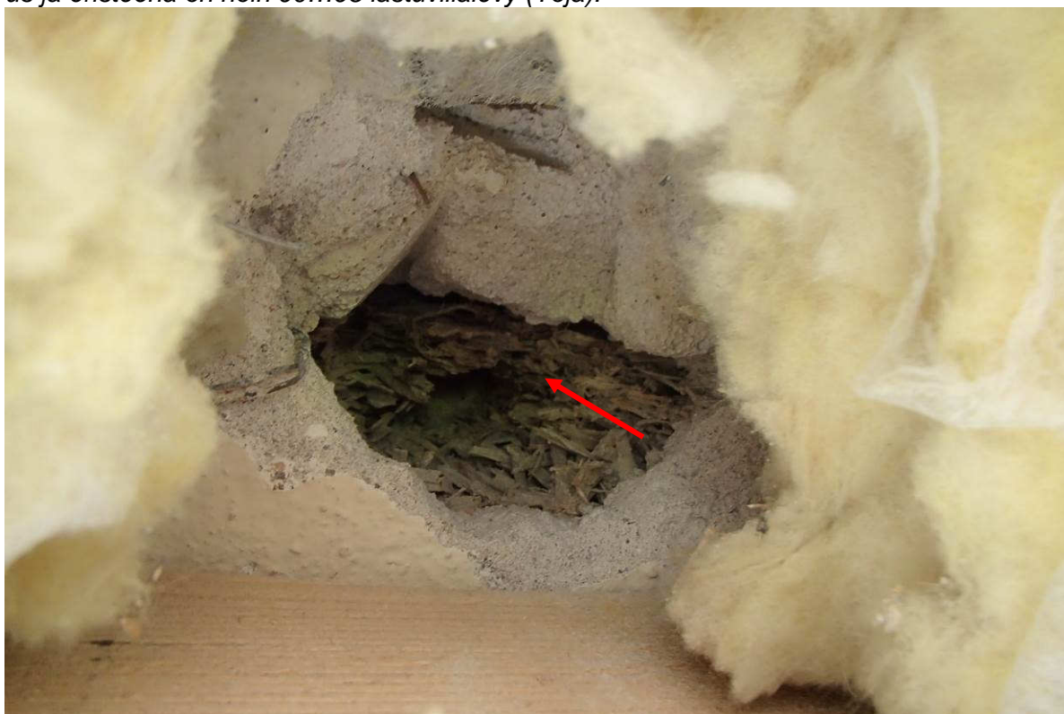
Kuva 11. Ulokkeen alapinnan alkuperäisenä lämmöneristeenä on lastuvillalevy (Toja).
