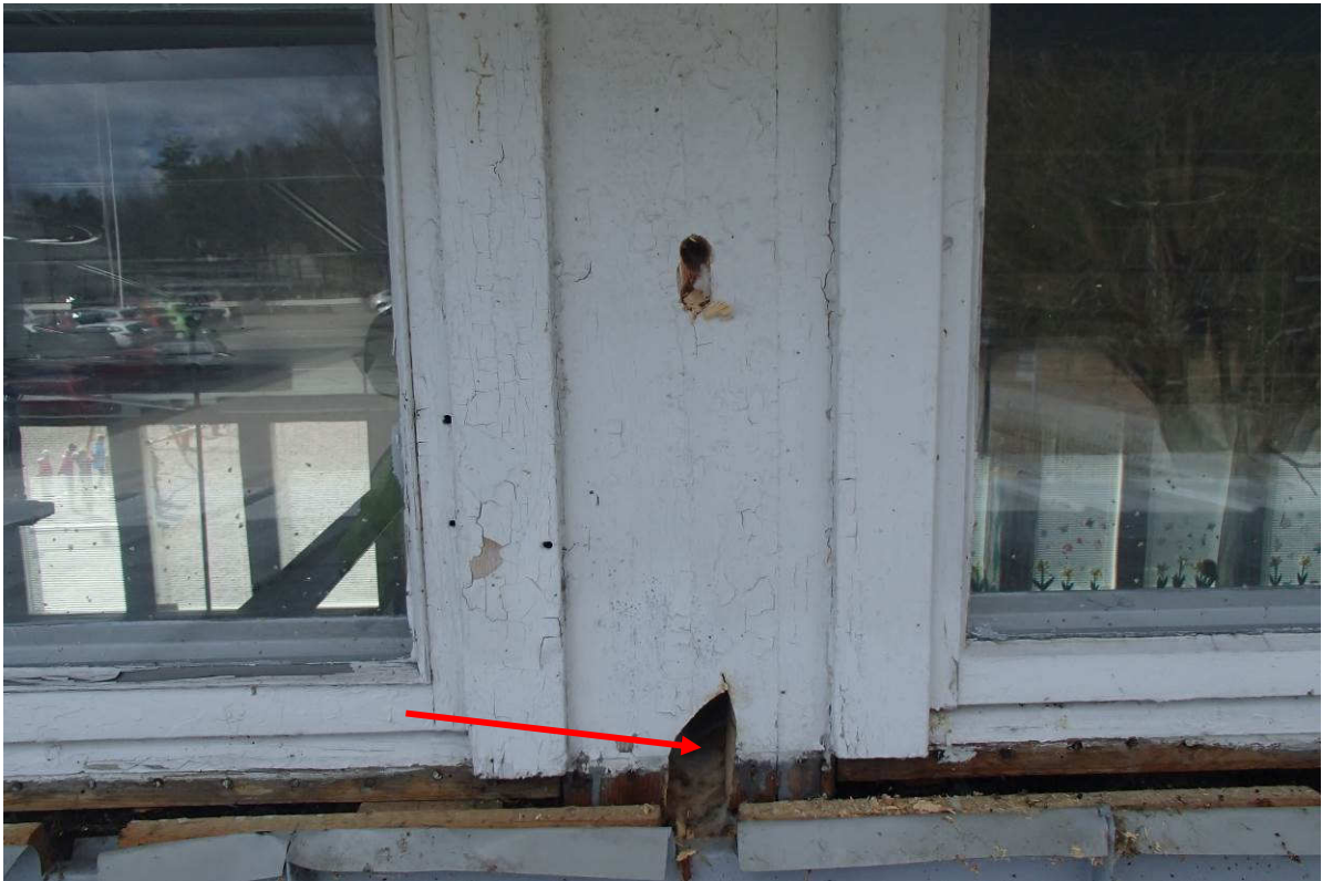
Kuva 20. Rakenneavaus luokkien väliseen seinään.
