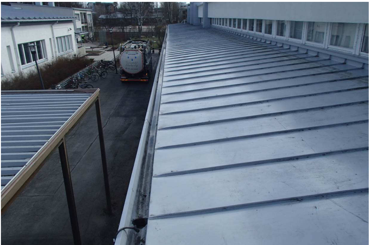
Kuva 39. Yleiskuva pohjoiseen kaatavalta vesikatolta.
