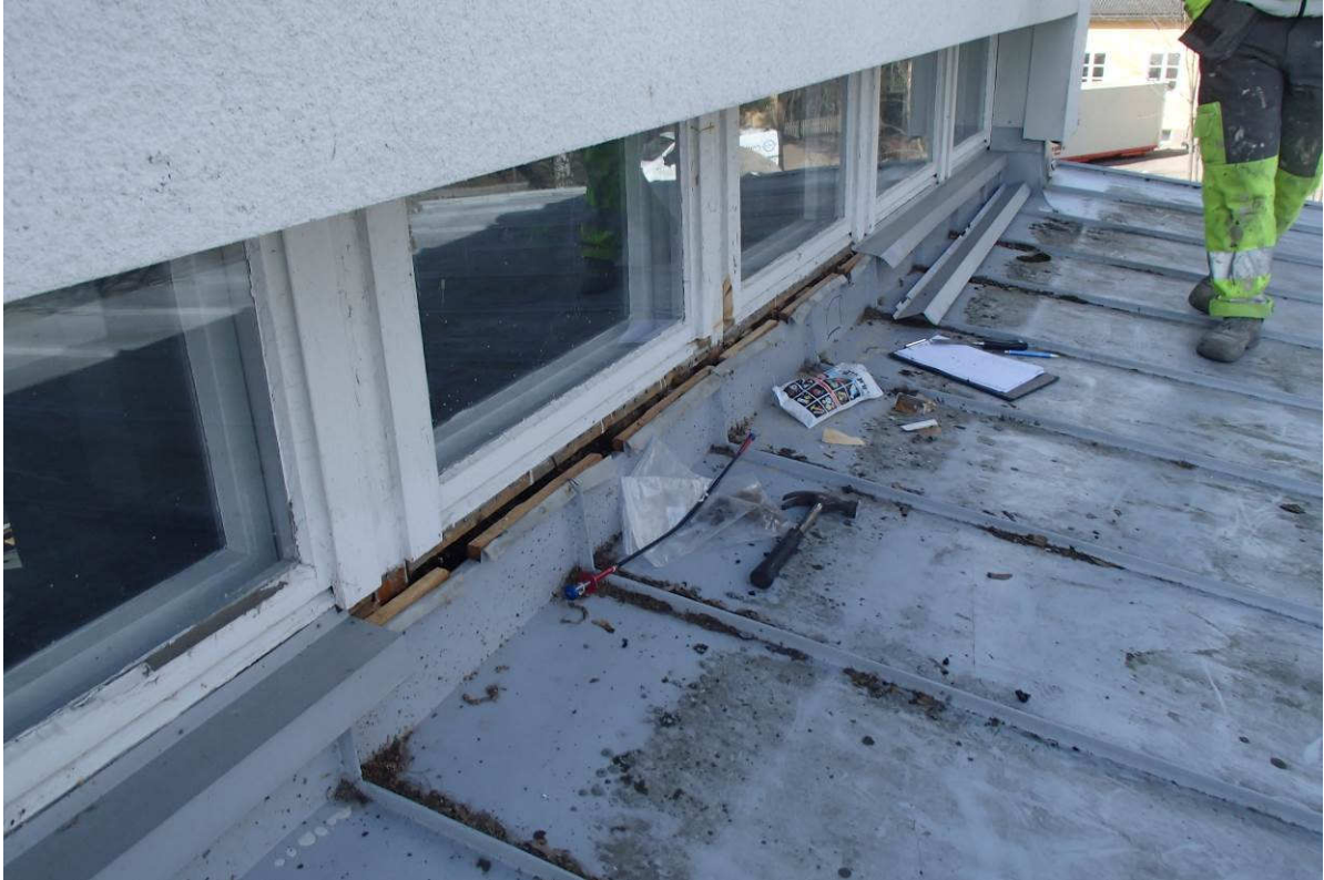
Kuva 14. Luokkahuoneen yläikkunan alaosan rakenneavaus.
