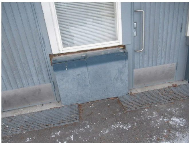
Kuva 3.4.5: Tarkastelujakson alussa suositellaan maalatut puu-ulko-ovet kunnostamaan ja pintakäsittämään.
