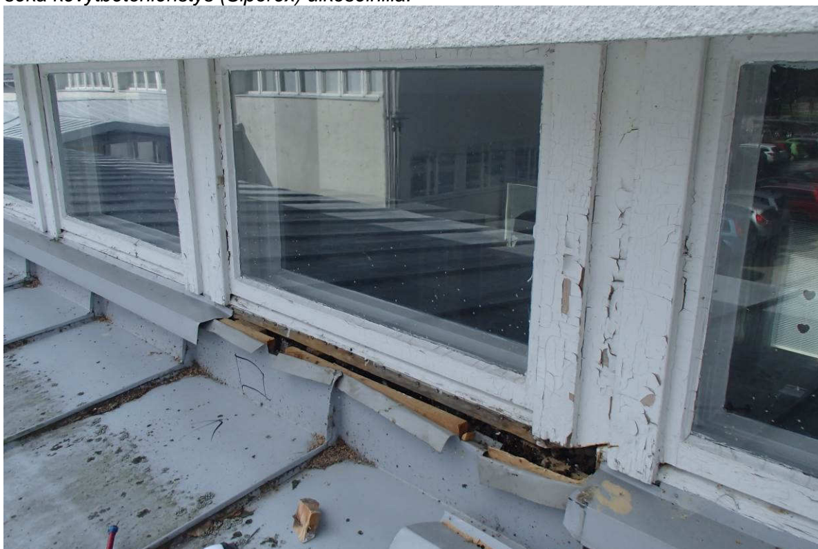
Kuva 13. Luokkahuoneen yläikkunan alaosan rakenneavaus.
