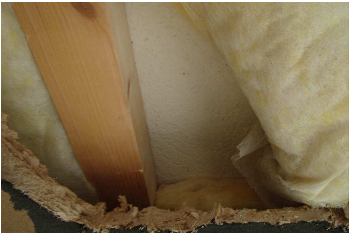
Kuva 9. Ulokkeen alapinnan lisäeristysten koolaus on kiinnitetty alkuperäiseen alapintaan.
