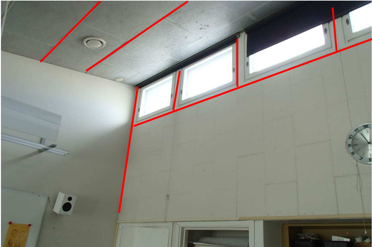
Kuva 60. Rakenneliitosten ilmavuotokohdat.
