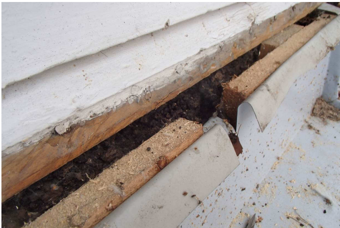
Kuva 16. Yläikkunan alaosan rakenneavaus.
