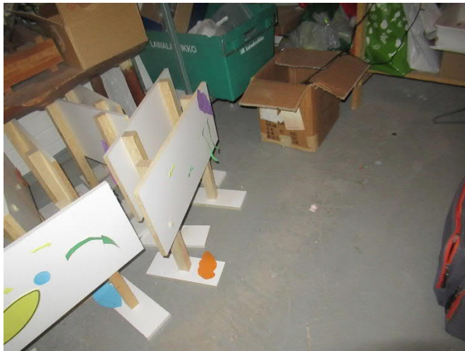
Kuva 3.6.1: Varastotilojen lattiamaalauksen kulumista ja hilseilyä.
