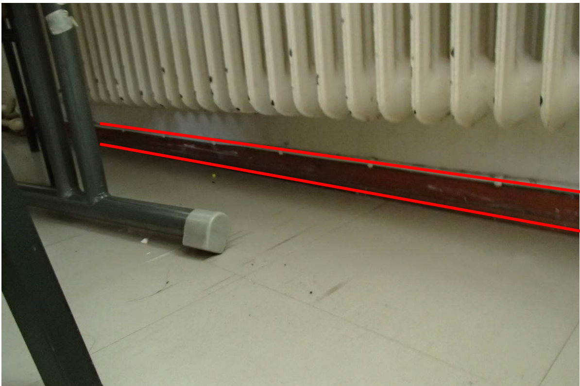
Kuva 61. Rakenneliitosten ilmavuotokohdat.
